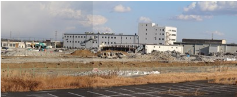
令和3年12月28日の状況（高崎線陸橋より撮影）です。正門と北門を結ぶ西門方面は108号建屋残して殆ど解体されました。（画面のテレビ側は#102の解体残骸です）
