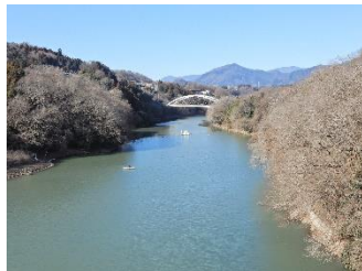
日連大橋の真ん中から相模川の上流側を見る。
